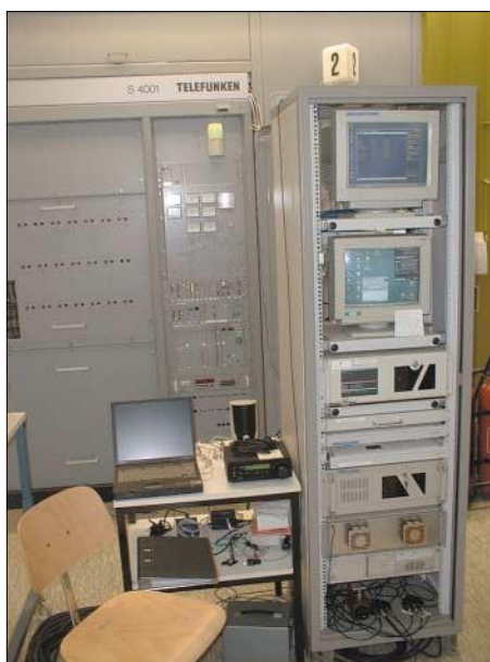
In diesem Teil der Anlage werden Sendungen in DRM-Technik aufbereitet und auf den Leistungsverstärker gegeben.
