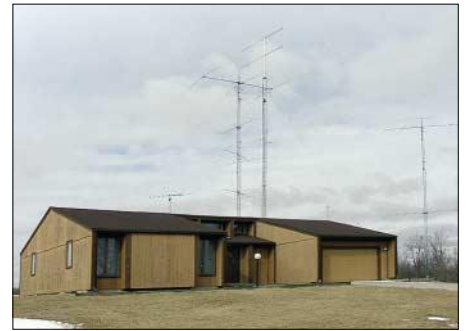
K8CC: Antennen mit Haus – Zwei der vier KW-Maste sind zu sehen; rechts UKW-Mast
