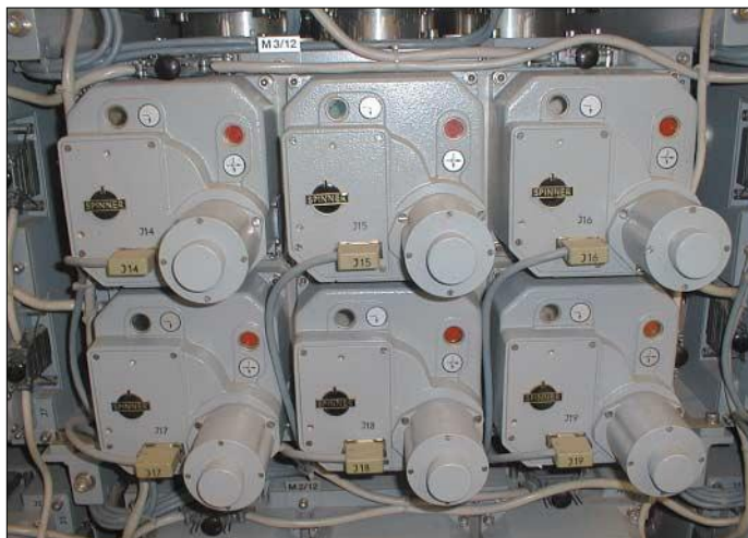
Durch eine massive Antennenmatrix in 50-Ω-Technik lassen sich die Signale der zwölf Sender auf insgesamt 42 Antennen schalten.
