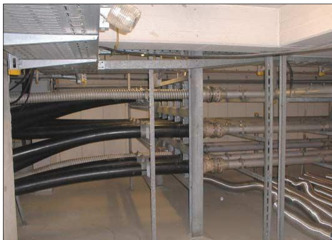
An diesen arm-dicken Kabeln im Keller des Gebäudes kann man fühlen, welcher Sender gerade „in der Luft“ ist.
